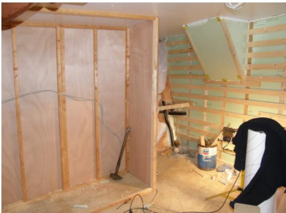
Erste Seitenwand wurde gezogen, dahinter liegt die Niedergangstreppe, vorn werden zwei Kojen eingebaut.
